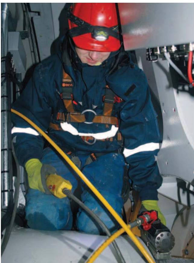
Serrer les vis au couple de serrage prévu.
