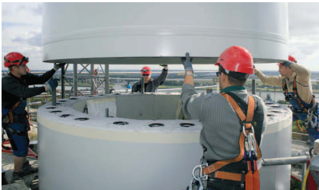
Parc éolien aciérie de Brême : Une équipe place la petite section acier pour le mât de 108 mètres.
