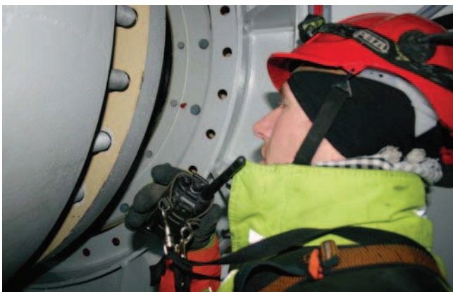
Daniel Sebbel guide le moyeu dans sa position finale.
