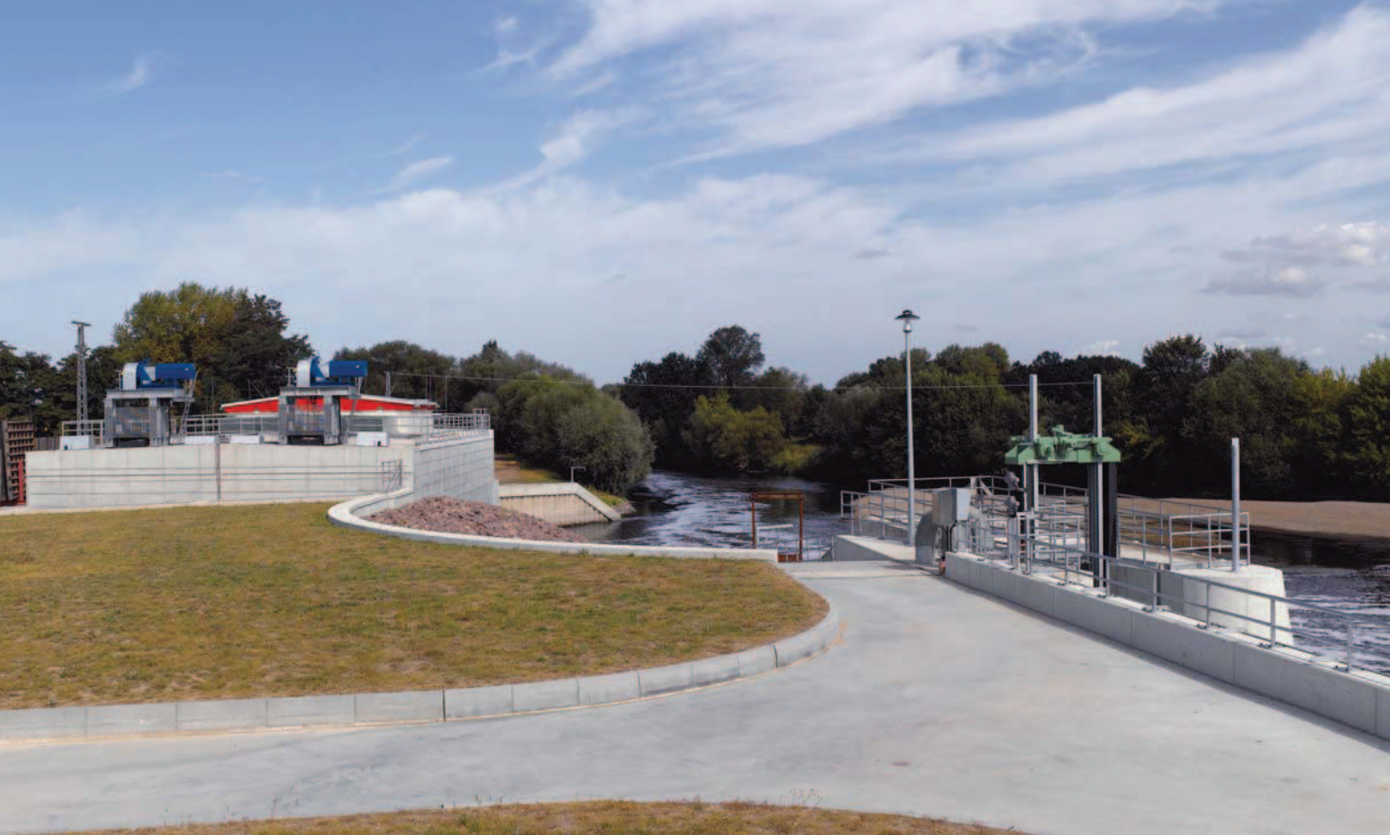
La première centrale hydroélectrique ENERCON : Bâtiment turbine à gauche, passage des poissons et canal de rinçage à droite.
