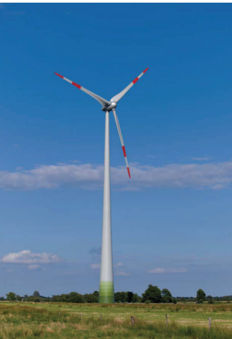
L'E-82/2,3 MW est en fonctionnement depuis février 2009 en Basse-Saxe.
