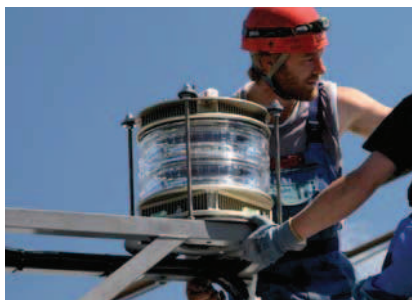
Installation d'un balisage d'obstacle.
