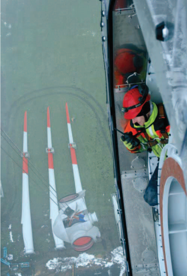
La levée du moyeu du rotor a commencé.
