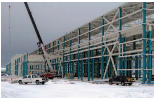
La nouvelle usine en construction à Matane / Canada.
