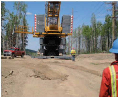
Déplacement de la grue sur chenilles à voie étroite.
